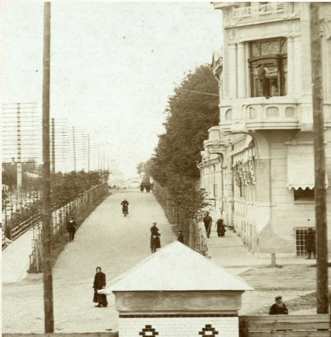
Вид из строящегося здания музея на "Бурьлинский бульвар" ( фото 1912-14 г.)
